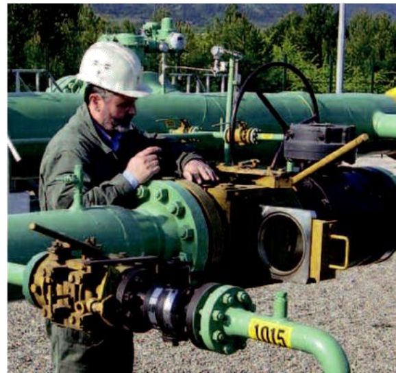
Заглушки ONIS PLB 8"600# и " 600# - Газогенераторная установка TIGF Barbeira
