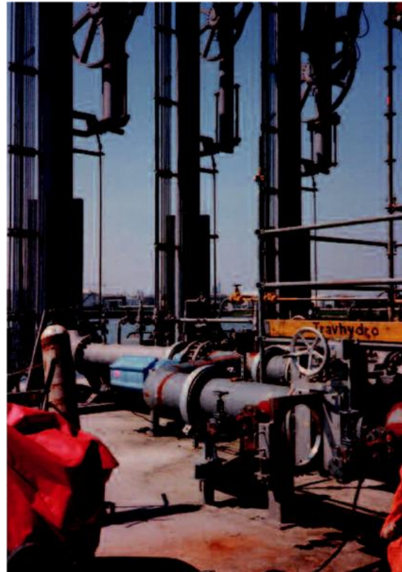
Заглушка ONIS PLR 400 (16") на загрузочных рукавах для отгрузки нефти
