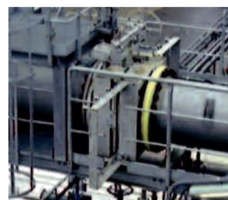
ONIS PLR 28" 150#, высокотемпературная, в сети факельных вышек установки гидрокрекинга - DEA - Германия
